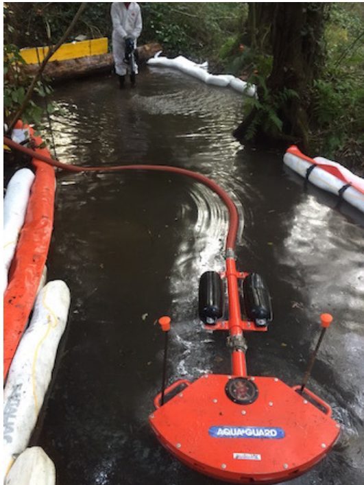
Foto 5. Attività diurna skimming e sostituzione fazzoletti al punto di risorgiva SUD (mappa 1 area 2)
