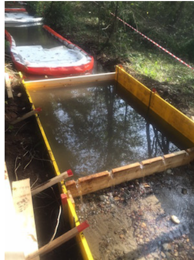
Foto 2. Barriera oleoassorbente a valle della vasca di filtrazione alla risorgiva SUD (mappa 1 area 2)
