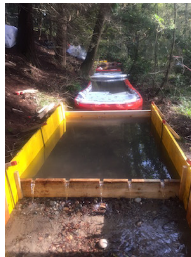
Foto 4. Attività skimming e sostituzione fazzoletti alla risorgiva SUD (mappa 1 area 2)
