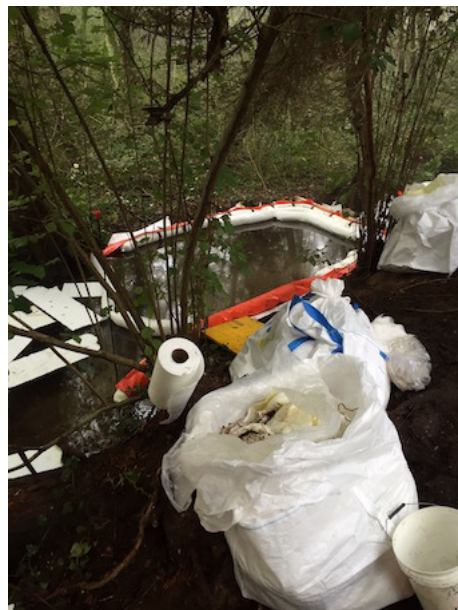
Foto 4. Attività diurna skimming e sostituzione fazzoletti al punto di risorgiva NORD (mappa 1 area 2)
