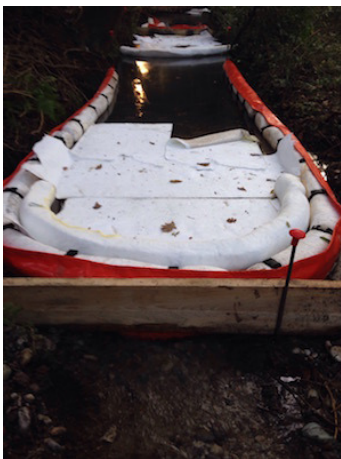
Foto 3. Attività skimming e sostituzione fazzoletti al punto di risorgiva SUD (mappa 1 area 2)
