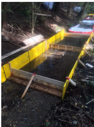
Foto 5. Realizzazione della vasca di filtrazione alla risorgiva SUD (mappa 1 area 2)
