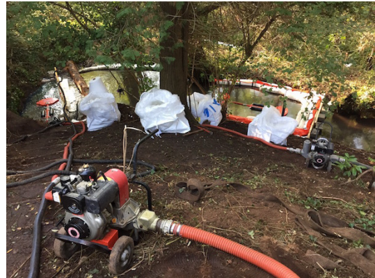
Foto 4. Attività diurna skimming e sostituzione fazzoletti al punto di risorgiva SUD (mappa 1 area 2)
