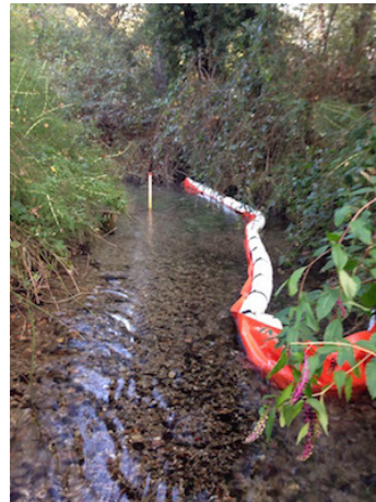
Foto 2. Barriera oleoassorbente e contenitivo nel punto di immissione nella roggia per risorgiva NORD (mappa 1 area 1)
