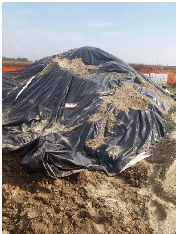
Fotografia 1: cumuli di terreno ricoperti da telo
