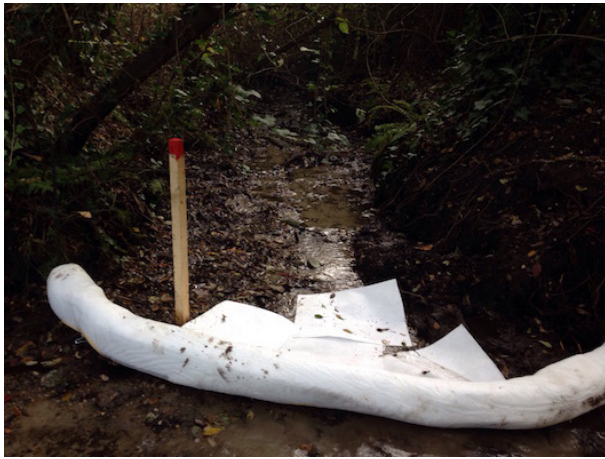
Foto 1. Barriera oleoassorbente nel punto di immissione nella roggia per risorgiva SUD (mappa 1 area 2)
