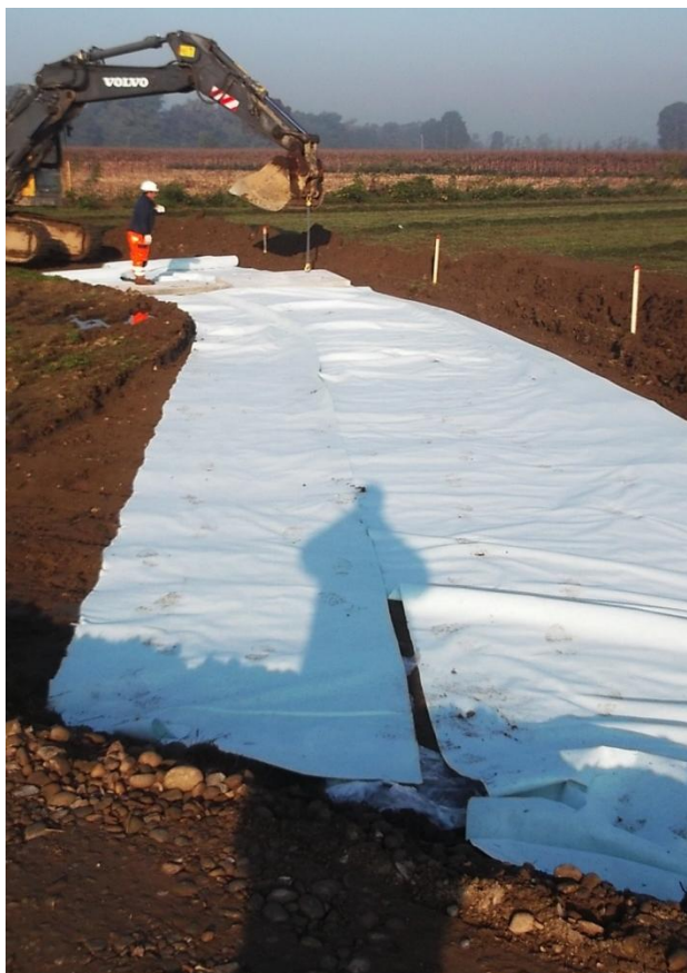
Fotografia 3: realizzazione pista di servizio
