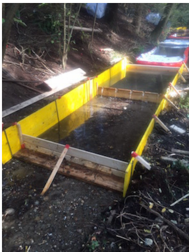
Foto 3. Realizzazione della vasca di filtrazione alla risorgiva SUD (mappa 1 area 2)
