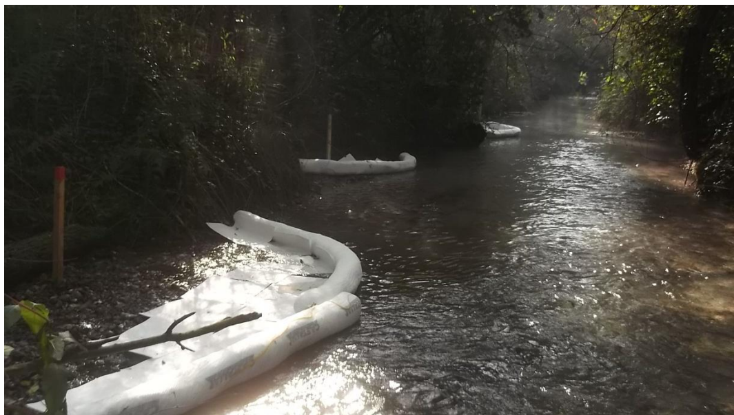
Fotografia 8: posizionamento panne e fogli nei diversi punti di ruscellamento in roggia Rabica.
